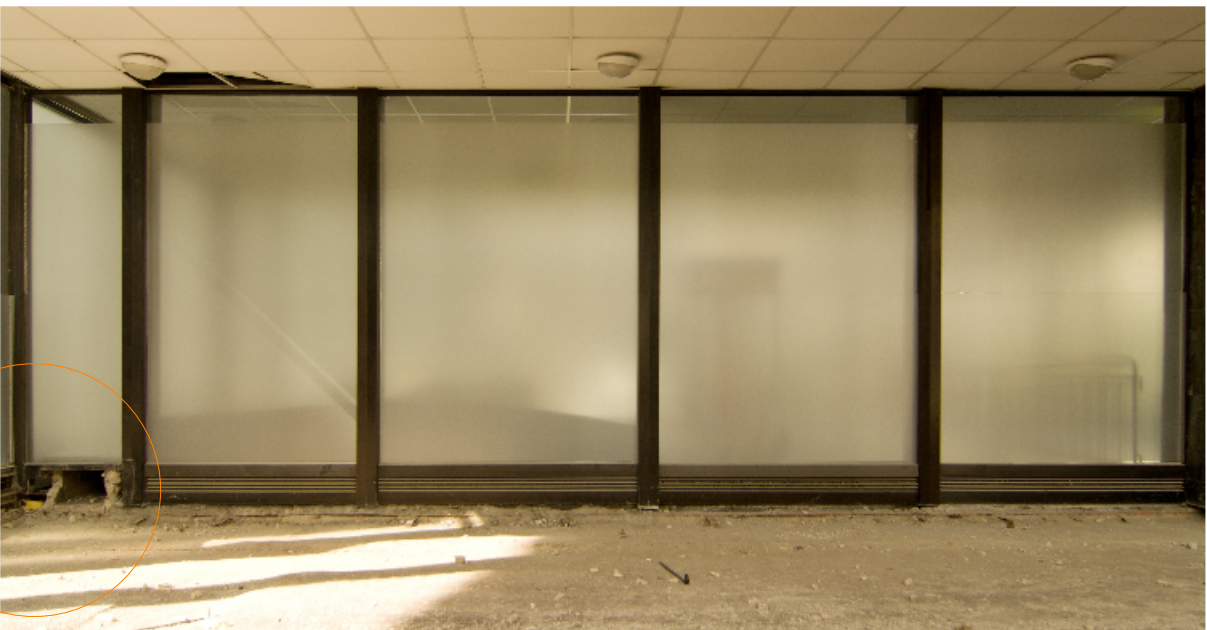
Stěna C, 1.NP pohled na vnitřní část, vlevo v rohu chybějící parapety.
